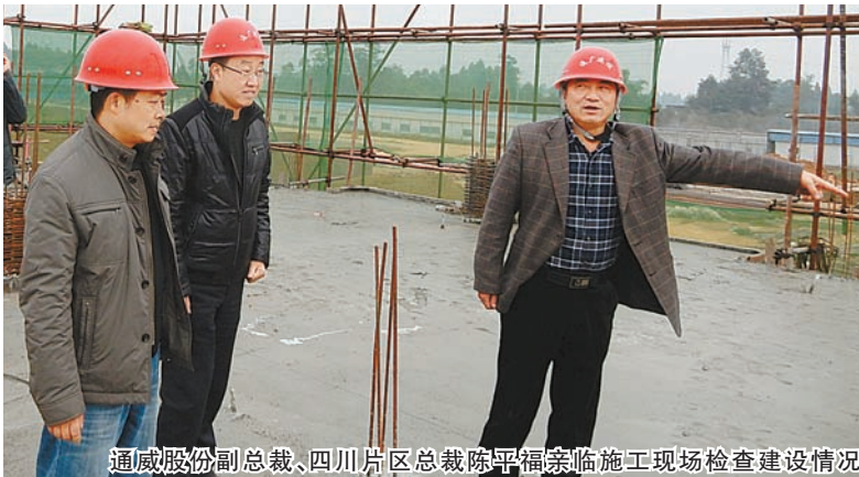
通威股份副总裁、四川片区总裁陈平福亲临施工现场检查建设情况
