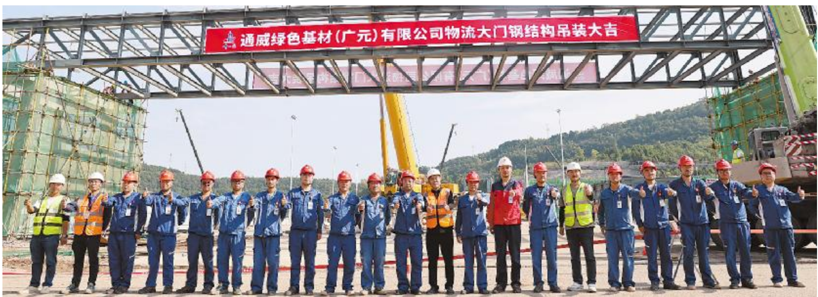
通威绿材(广元)项目厂区物流大门钢结构吊装圆满成功
