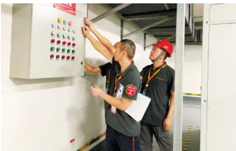
成都基地开展电气安全专项检查
